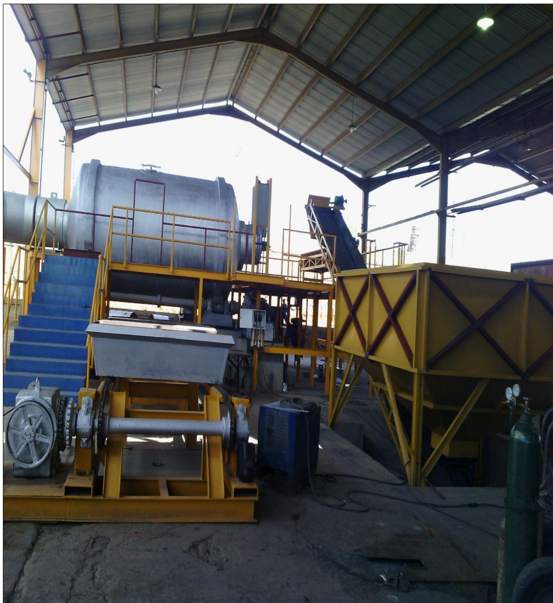
Sistema de carga y fundición
