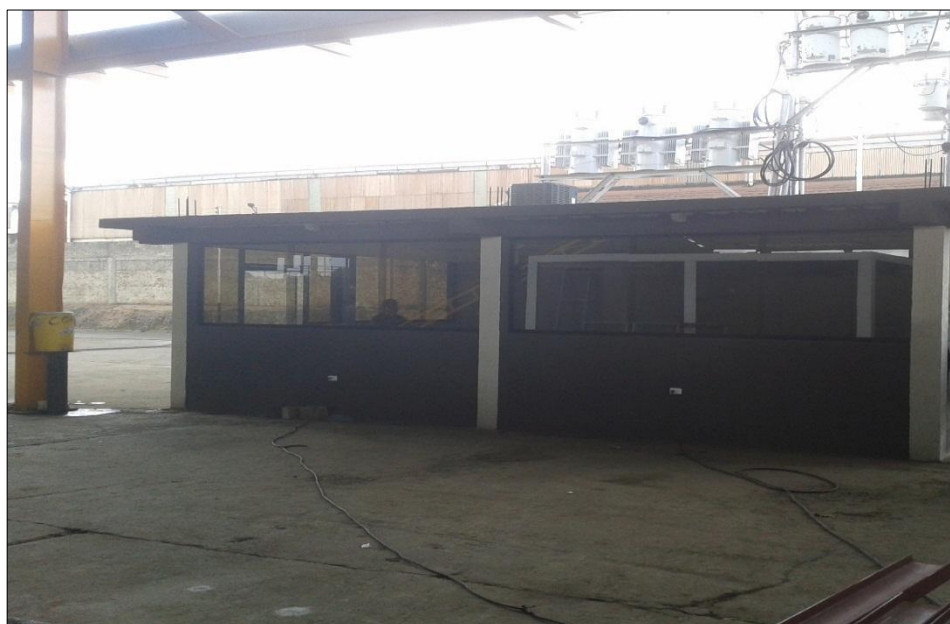
Sala de control de la línea de producción 3
