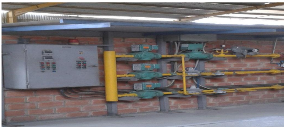
Sistema automatizado de encendido y operación de los quemadores
